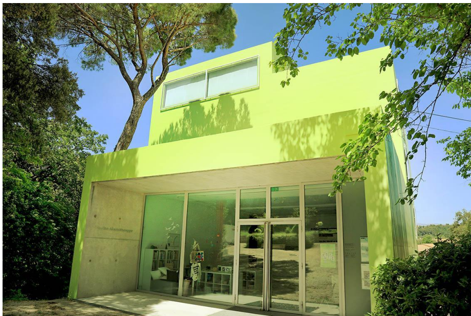
2. ábra: Donation Albers-Honegger, architectes Gigon & Guyer © crédit photo Bruno Gros
